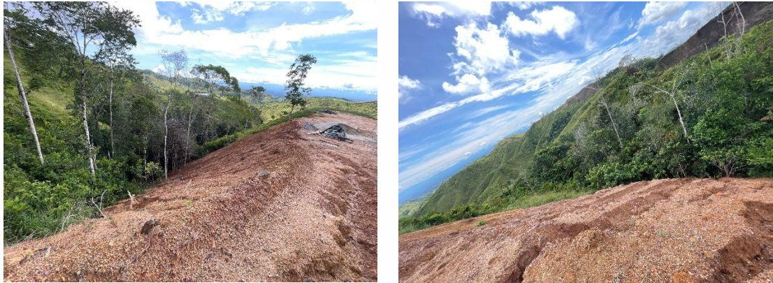
Figura 5. Taludes conformados para las explanaciones. Fuente Cornare 2025
