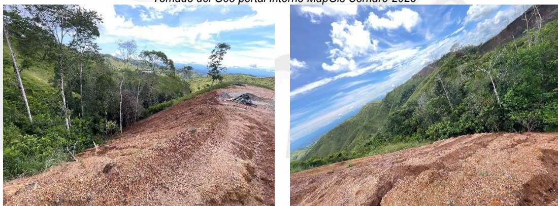
Figura 5. Taludes conformados para las explanaciones. Fuente Cornare 2025
