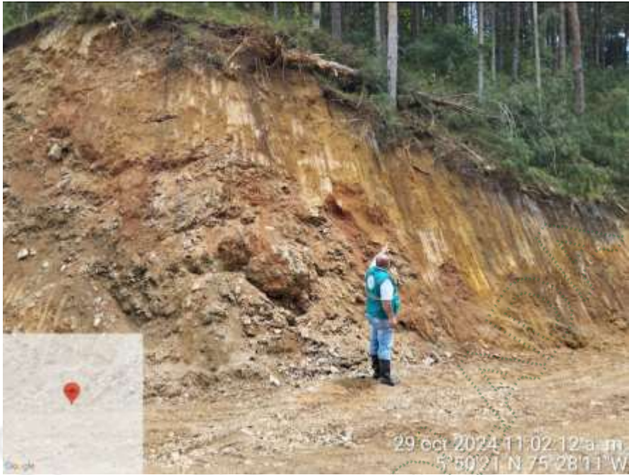
Evidencia de taludes que superan los 5 metros de alto
