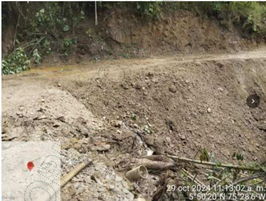
Para cruzar la fuente se instaló un tubo en Novafort de 8 pulgadas
