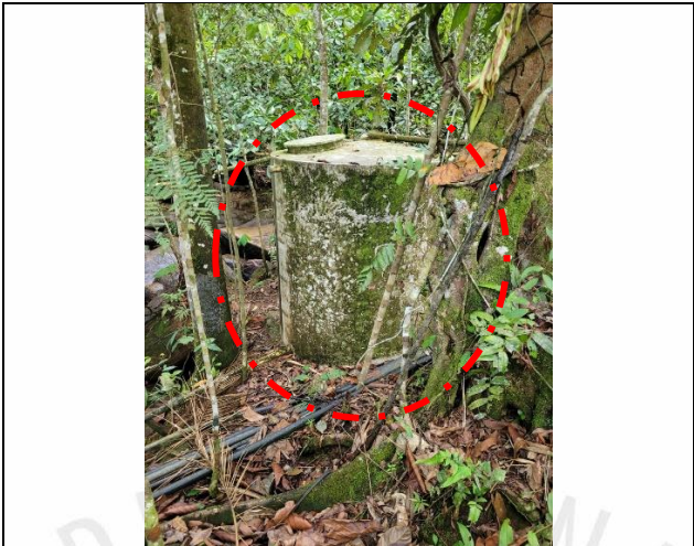
Figura 3. Tanque de almacenamiento, aprovechamiento de agua, para USO DOMÉSTICO, que beneficia el Sector La Sirena
