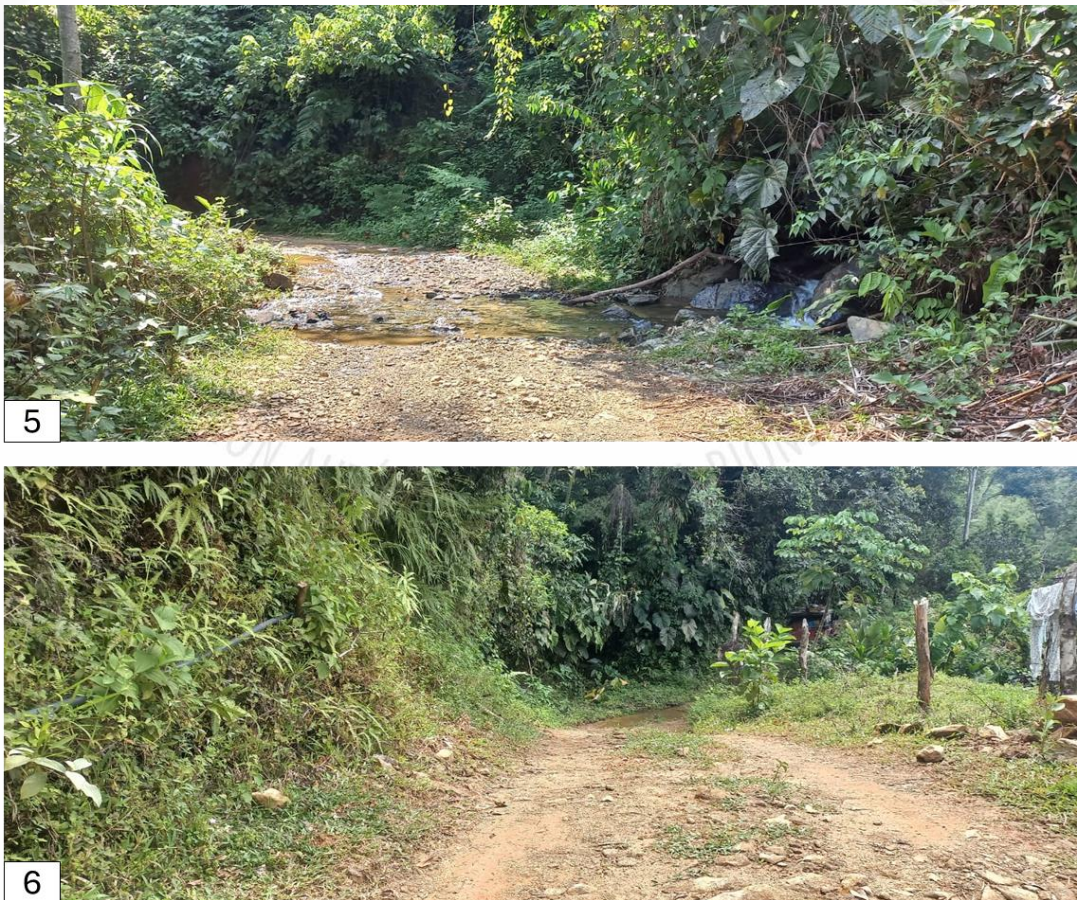
Figura 5 y 6: Apertura de la vía. Fuente: Cornare, 2024
