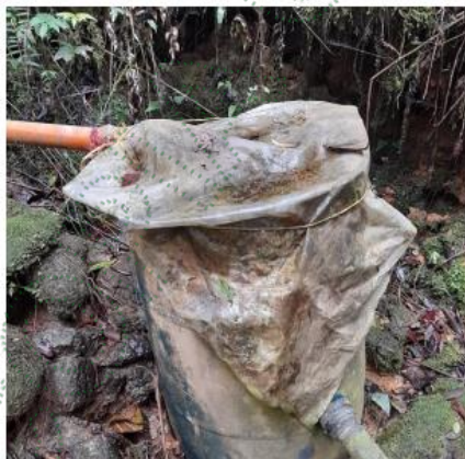
Fotografías 5. Obra de captación de las señoras: María Elizabeth Montoya Restrepo con cedula 321.815.899 y Gloria Amparo Saldarriaga López
