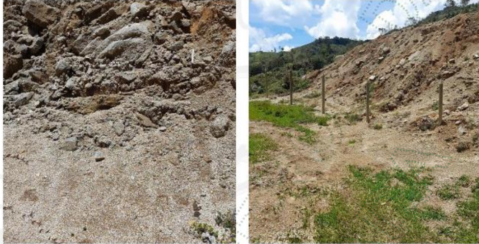
Fotografías de la 3 y 4. Explanación 2, estado del material en el momento de la visita.
