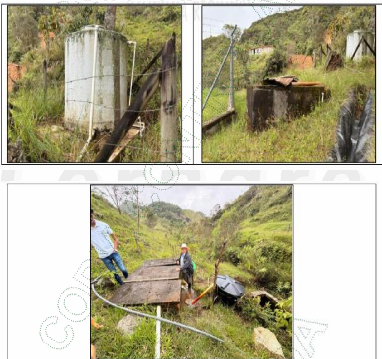
Imagen 1. Tanque de Almacenamiento y punto de captación.
