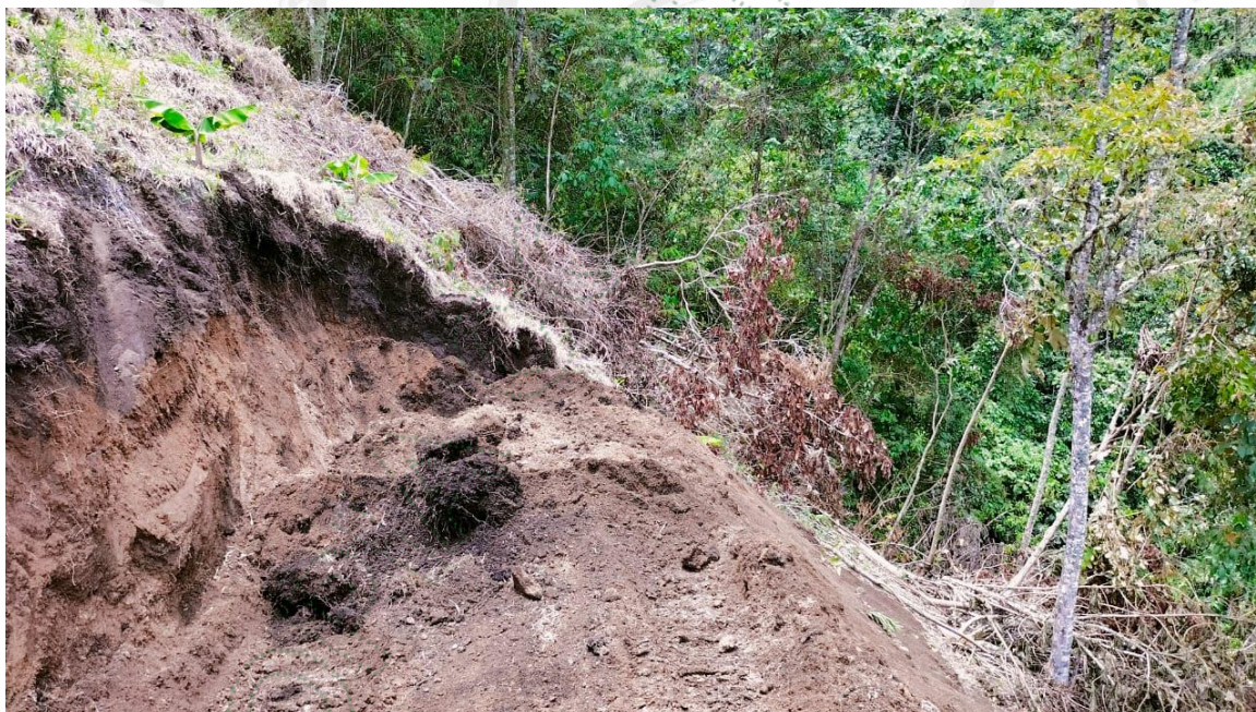
Imagen: Punto donde se encontraba trabajando la maquina amarilla, cercana a una fuente hídrica No. 3.
