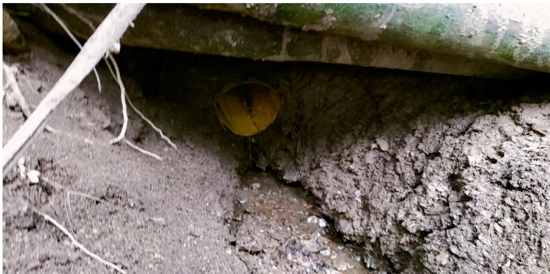
Imagen 3. Se instaló un tubo de material PVC como obra de desagüe de la fuente hídrica No. 1
