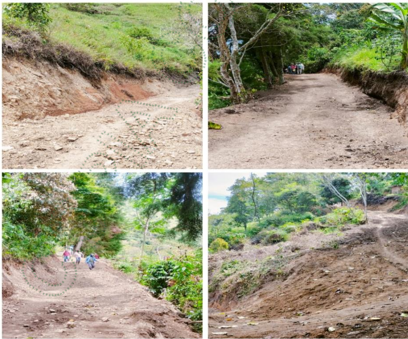
Imágenes 1, 2, 3, 4 5, 6, 7 y 8: conformación de la vía en diferentes puntos.
