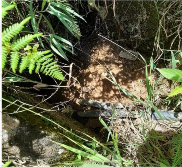
Fotografía 2. Mangueras de descarga, sobre la Obra de Drenaje Transversal.
