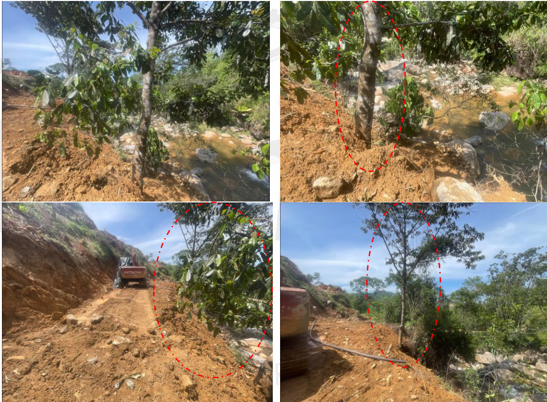
Figura 3. Estado de los árboles afectado y fuente hídrica por actividad de movimiento de tierras. Fuente: Cornare 2026
