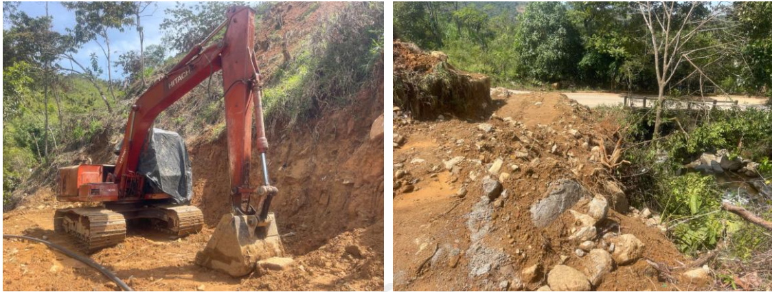
Figura 1. Evidencias fotográficas de las actividades de movimiento de tierras en el sitio con coordenada geográfica -75°0'37.26" W, 6°3'9.48" N, sobre la ronda hídrica de la Quebrada La confusa.
