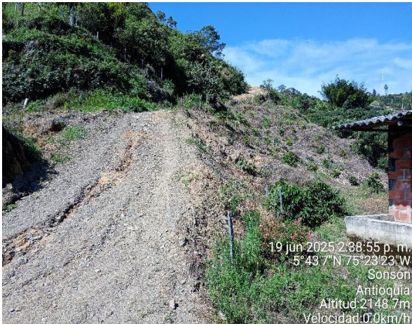
Panorámica del tramo intervenido
