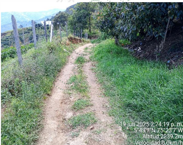
Inicio adecuación carretable
