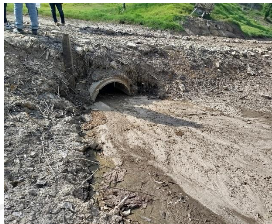
Foto 6. Obra transversal 2 en vía existente.
