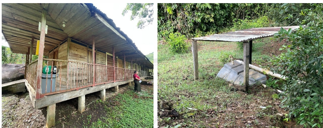
Imagen 3. Cabaña y sistema séptico del predio con FMI: 018-162639, el cual hace parte del Restaurante Los Aragones. Fuente Cornare 2026
