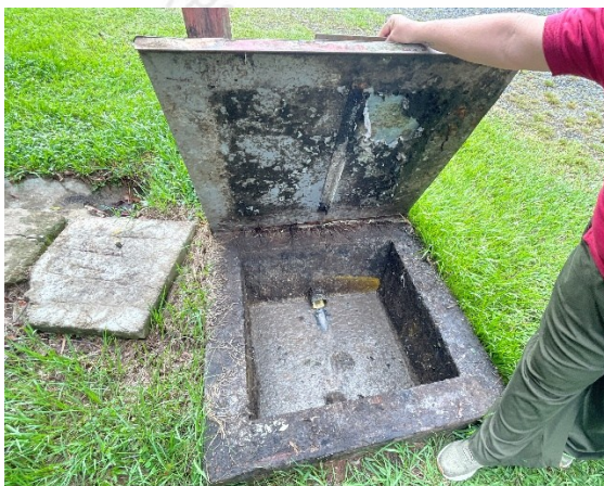
Imagen 2. Sistema de tratamiento implementado para manejar las aguas residuales domésticas del Restaurante Los Aragoes. Fuente: Cornare 2026
