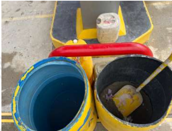
Foto 6. Caneca de material absorbente de la EDS El Mármol. Fuente: Cornare 2024
