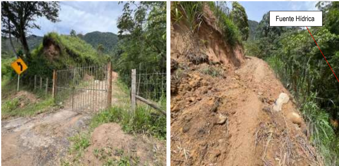
Foto 1 y 2. Ingreso hacia los predios 1, 2 y 3, donde se realiza el movimiento de tierras y loteo. Fuente : Cornare 2024
