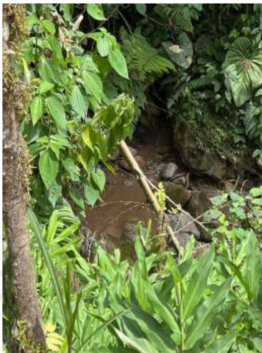
Foto 17. Sedimento sobre la quebrada “sin nombre” debido a actividad de movimiento de tierras. Fuente Cornare 2024.
