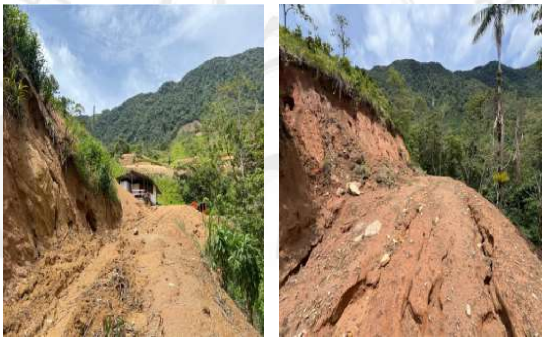
Fotos 15 y 16. Algunos taludes de la apertura de vía. Fuente: Cornare 2024.
