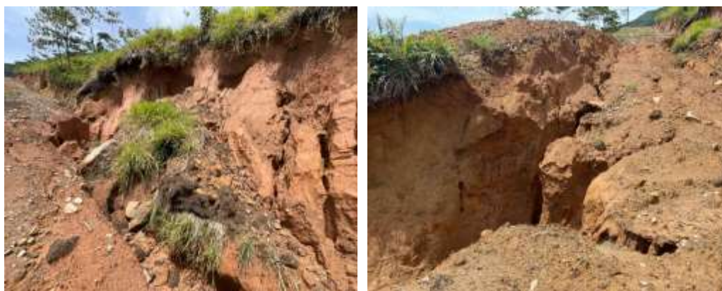
Fotos 9, 10, 11, 12, 13 y 14. Conformaciones de surcos y cárcavas debido a mal manejo de aguas lluvias en las actividades de movimientos de tierras, sobre los predios 1,2 y 3. Fuente: Cornare 2024.
