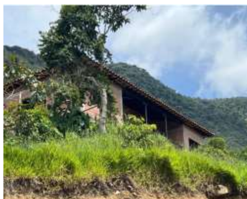
Fotos 8. Vivienda en construcción. Fuente: Cornare 2024
