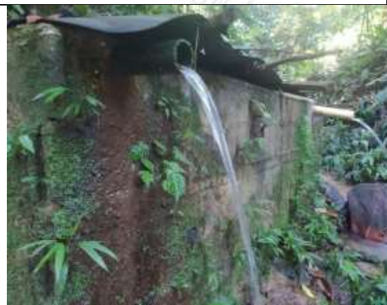
Figura 9. Tanque de abastecimiento y desarenador del predio 7.
