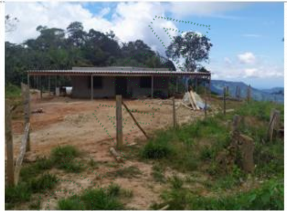
Construcción de vivienda en el área donde se conformó la explanación.
