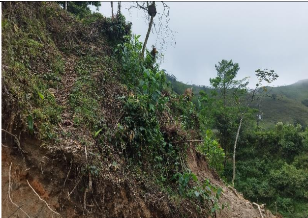
Talud y árbol talado
