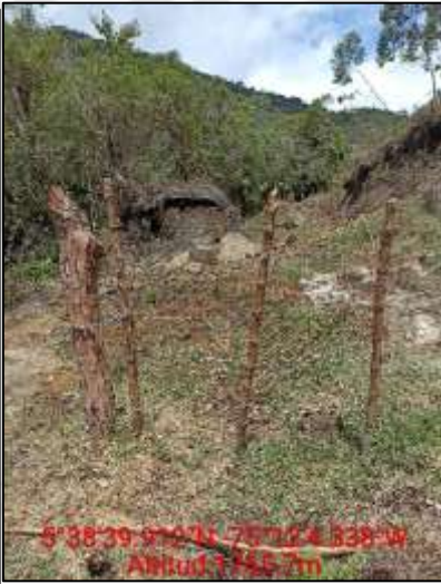
Entrada al predio afectado
