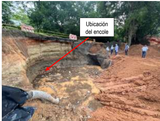
Foto 4 y 5. Jarillón provisional de contención de la quebrada “Cañada Inés”, ubicación de la motobomba y cara lateral de la estructura de la vía –Autopista Medellín Bogotá PR 119+600. Fuente: Cornare 2024.
