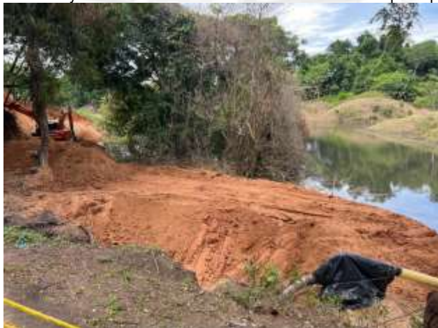
Foto 4 y 5. Jarillón provisional de contención de la quebrada “Cañada Inés”, ubicación de la motobomba y cara lateral de la estructura de la vía –Autopista Medellín Bogotá PR 119+600. Fuente: Cornare 2024.
