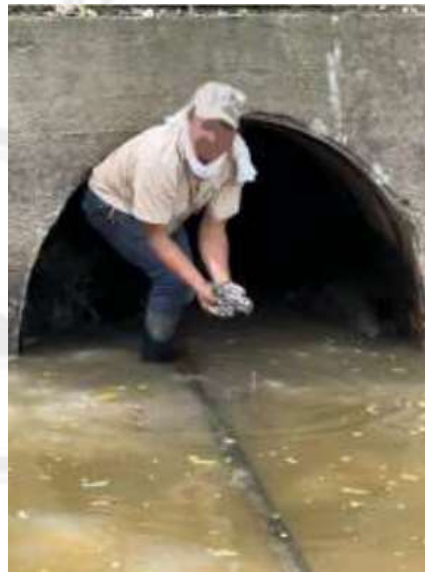
Foto 12. Material que se encuentra dentro de la obra hidráulica transversal que ocupa la mitad de su diámetro. Fuente: Cornare 2024
