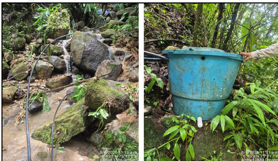
Imagen 2: Sistema no regulado de captación de agua en la fuente hídrica 2. Fuente: Cornare, 2026
