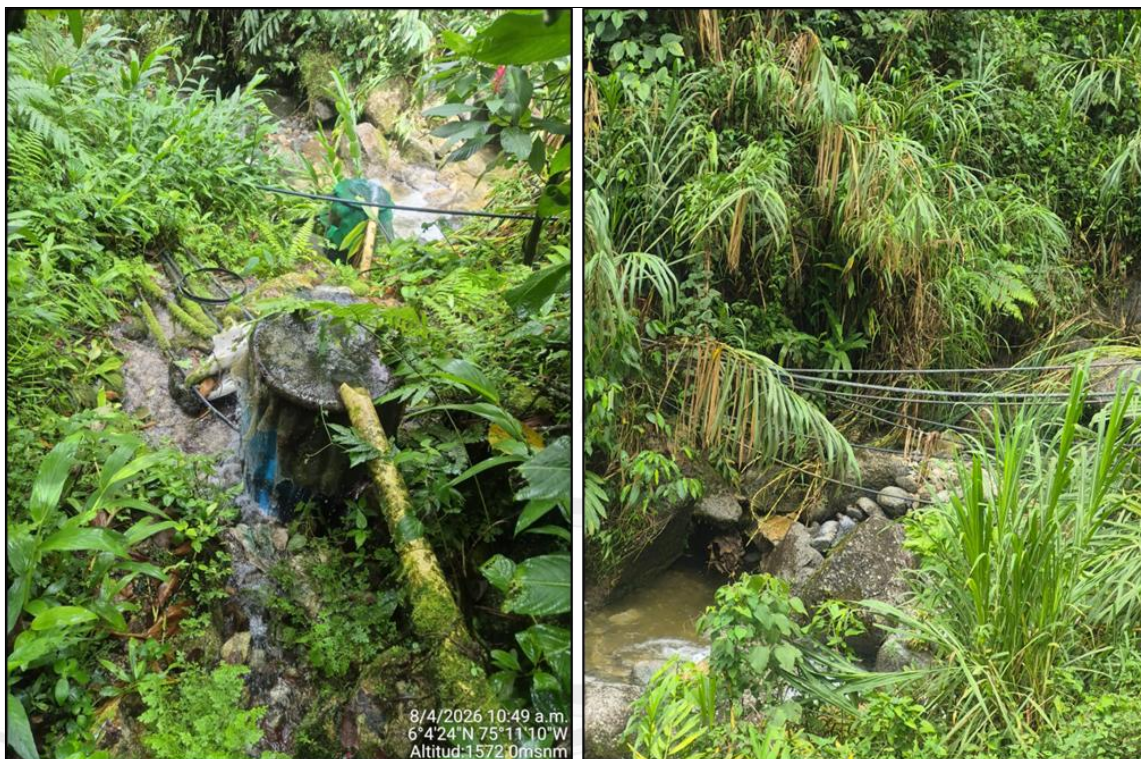
Imagen 1: Sistema no regulado de captación de agua fuente hídrica 1. Fuente: Cornare, 2026
