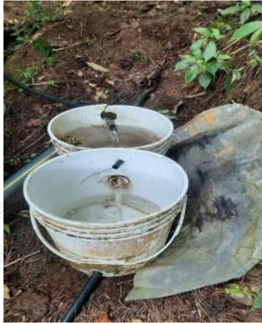
Sistema de control de caudal en la fuente la Sonadora Fuente La Escuela El Capiro
