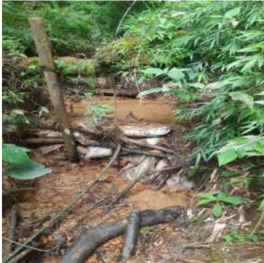
Presa de derivación rudimentaria en la fuente la sonadora - Cámara de toma directa en la fuente la Escuela El Capiro.
