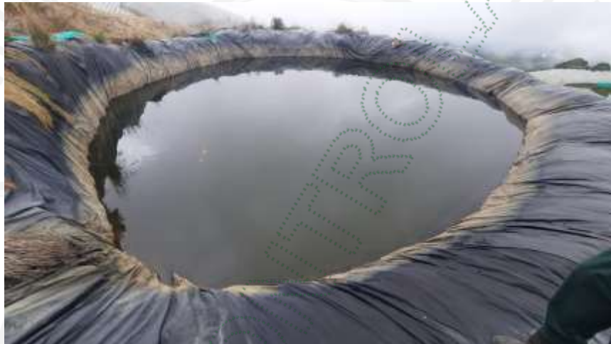
Sistema de almacenamiento revestido de 250mil litros
