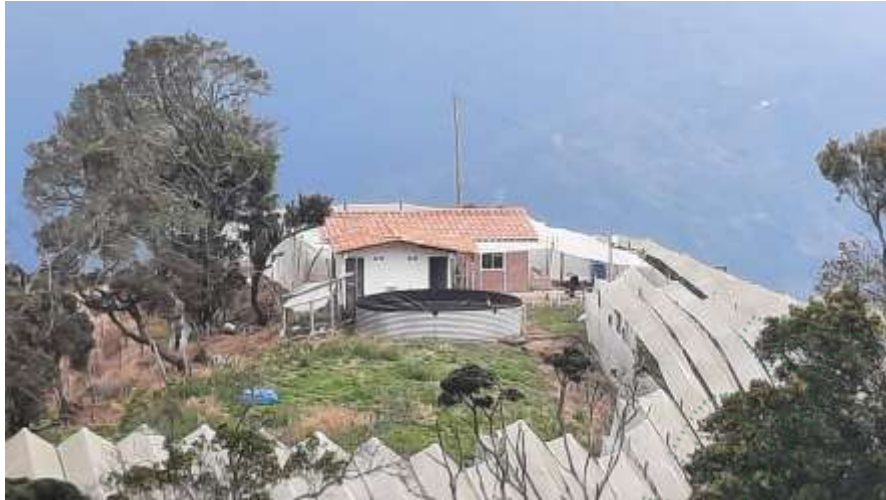
Tanque de almacenamiento de 50mil litros
