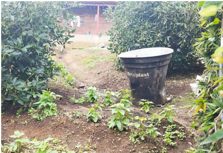
Tanque donde llegaban las aguas del lavado de café el cual fue retirado por mal manejo
