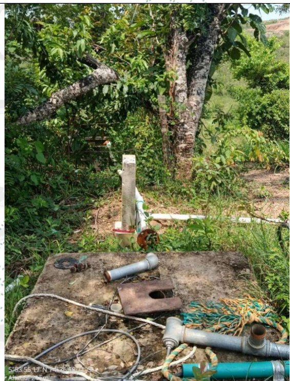
Imagen5. Sistema de captación (Pozo subterráneo). Fuente: Cornare 2026
