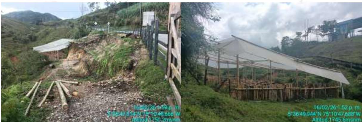
Caballerizas construidas en ocupando el cauce de la fuente
