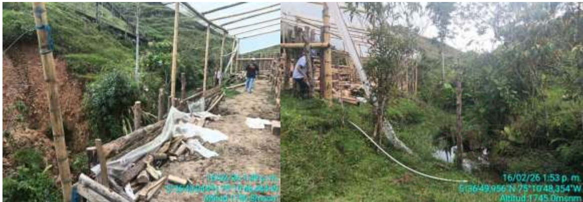
Construcción con piso en tierra ocupando el cauce de la fuente
