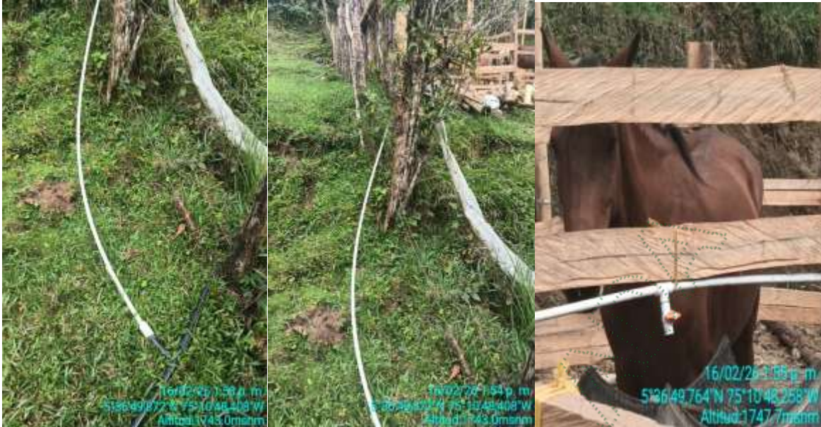
Captación de aguas derivada por manguera para los bebederos de los 14 corrales.
