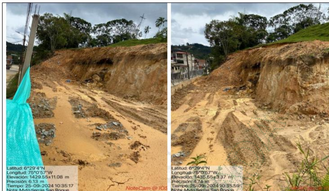
Imágenes 3 y 4. Movimiento de tierras en el predio con PK_PREDIOS 6701001001003000014
