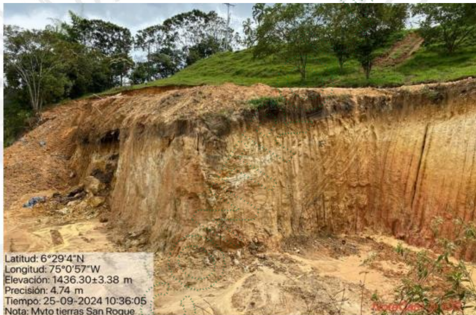
Imagen 2. Movimiento de tierras en el predio con PK_PREDIOS 6701001001003000014
