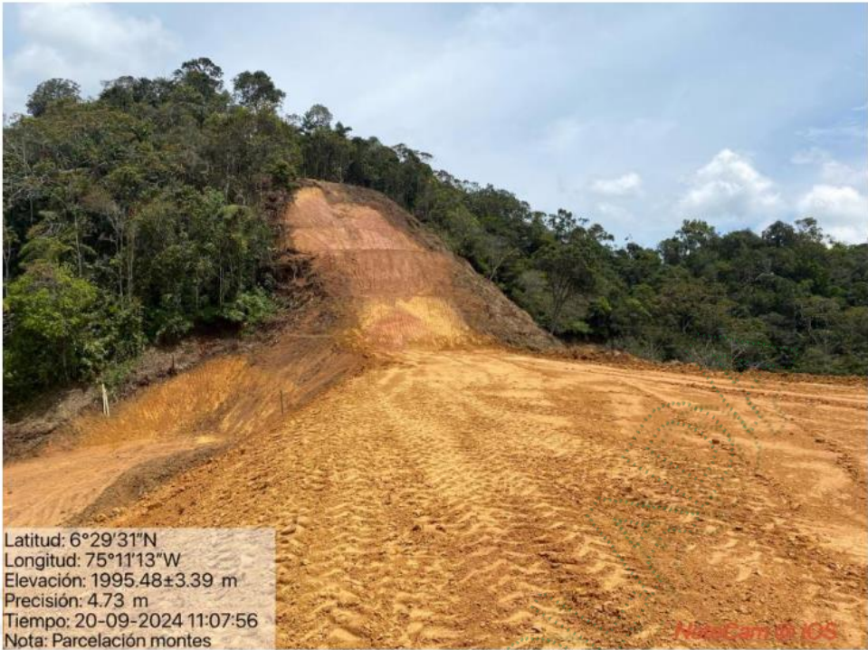
Imagen 2. Labores de movimiento de tierras.
