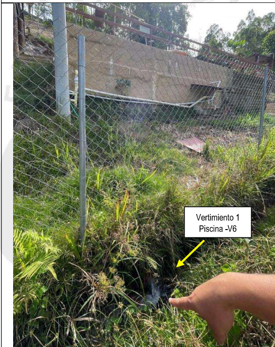
Imagen 17. Vertimiento V6, ubicado en las coordenadas 74^{\circ} 59' 33,71'' - 6^{\circ} 2' 55,35'' , proveniente de una piscina. Fuente: Cornare 2026.
