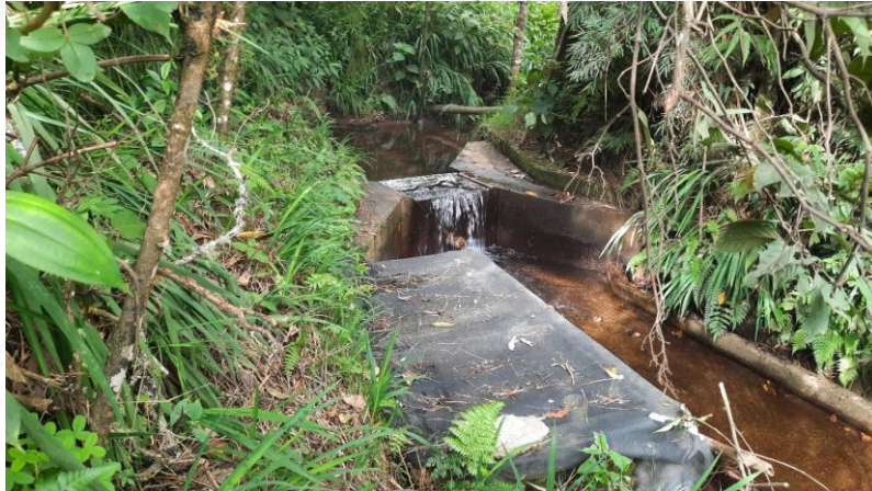
Obra de captación estable y sin sedimentación
