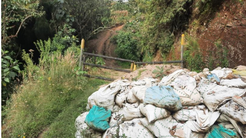
Sitio donde inicio la apertura de vía y sitio de ingreso de vehículos, el cual está taponado por tierra y bolsa creto para evitar cualquier ingreso.
