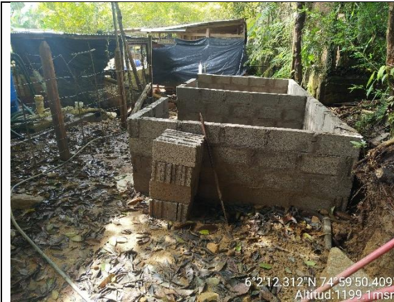
Figura 2. Construcción de corrales nuevo en el sitio.
