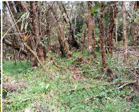
Acondicionamiento de área (tala de árboles)
