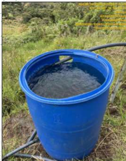
Imagen Nro.3: Tanque de almacenamiento sin dispositivo de control de flujo.
