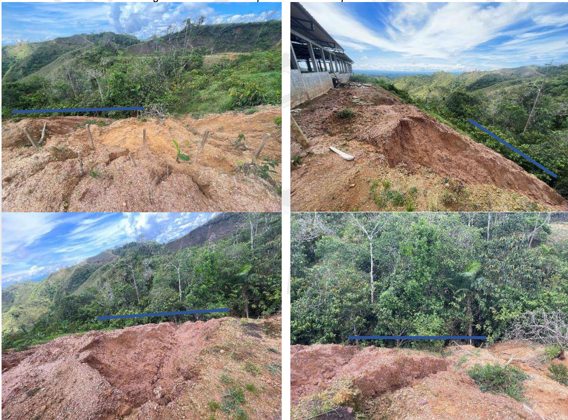
Figura 5. Taludes conformados para las explanaciones con cárcavas de diferentes tamaños Línea azul, paso de fuentes hídricas Fuente Cornare 2026
