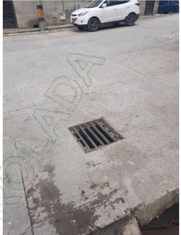
Conexión a alcantarillado
