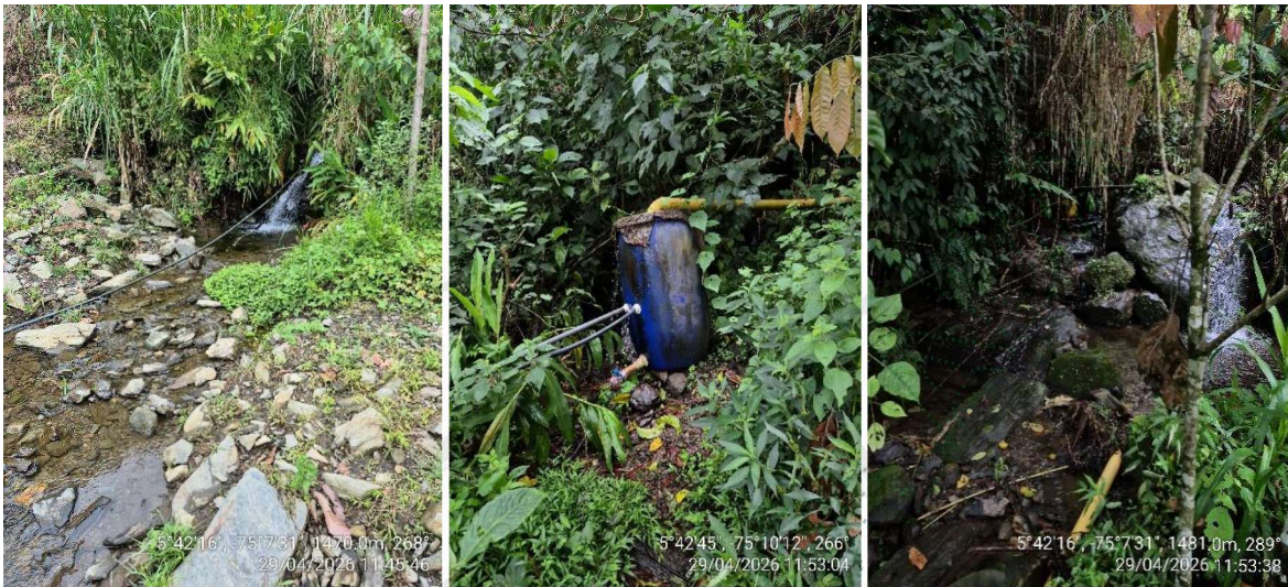
Imagen 3. Izquierda. Paso de tuberías por la carretera nueva. Centro. Recipiente de captación del agua, en donde se observa que salen dos tuberías. Derecha. Punto de captación en la fuente.
