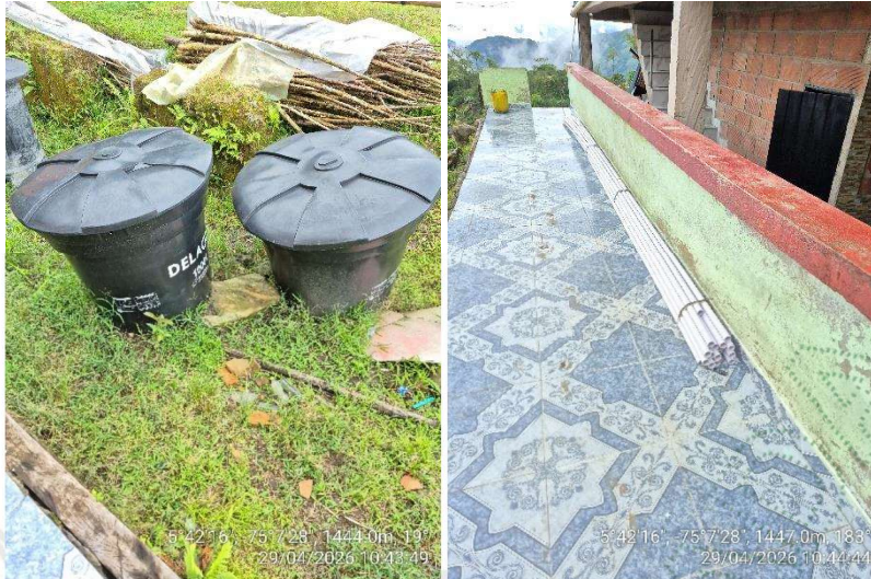
Imagen 1. Tanques de almacenamiento y tubería del acueducto.
