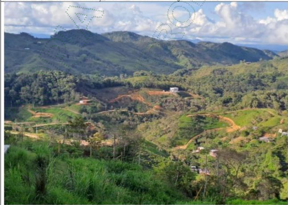
Fotografía 7. Panorámica de la parcelación Montes de Santo Domingo.
