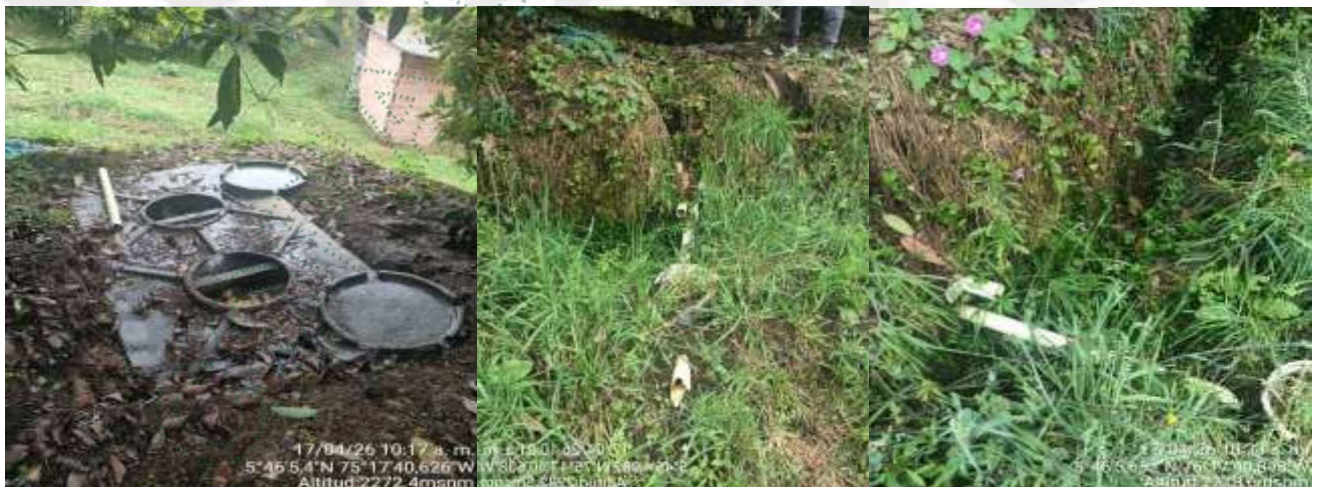
Sistema séptico predio con folio 028-17022 y salida hacia la fuente
