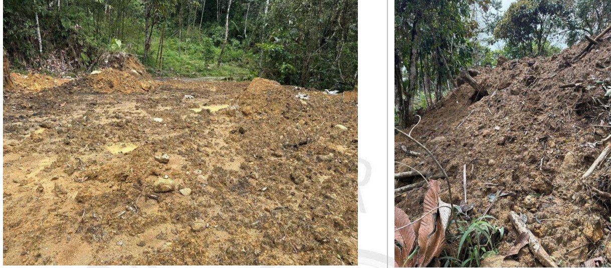
Movimiento de tierra.
