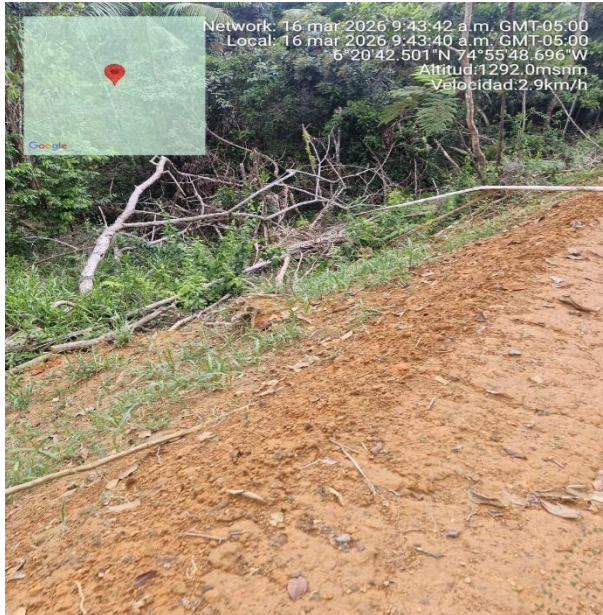
Imagen 7 . Siembra de material vegetal en los taludes Cornare 2026
