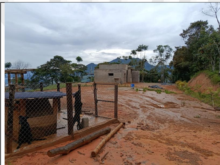
Imagen 3. Casa en construcción
