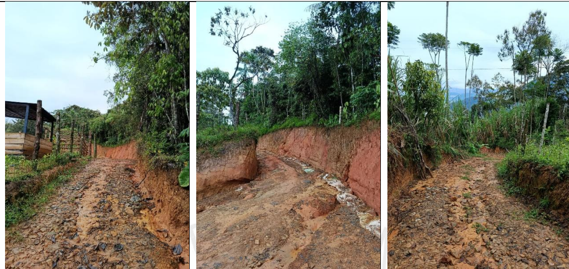
Imagen 5, 6 y 7. Estado actual de la vía.
