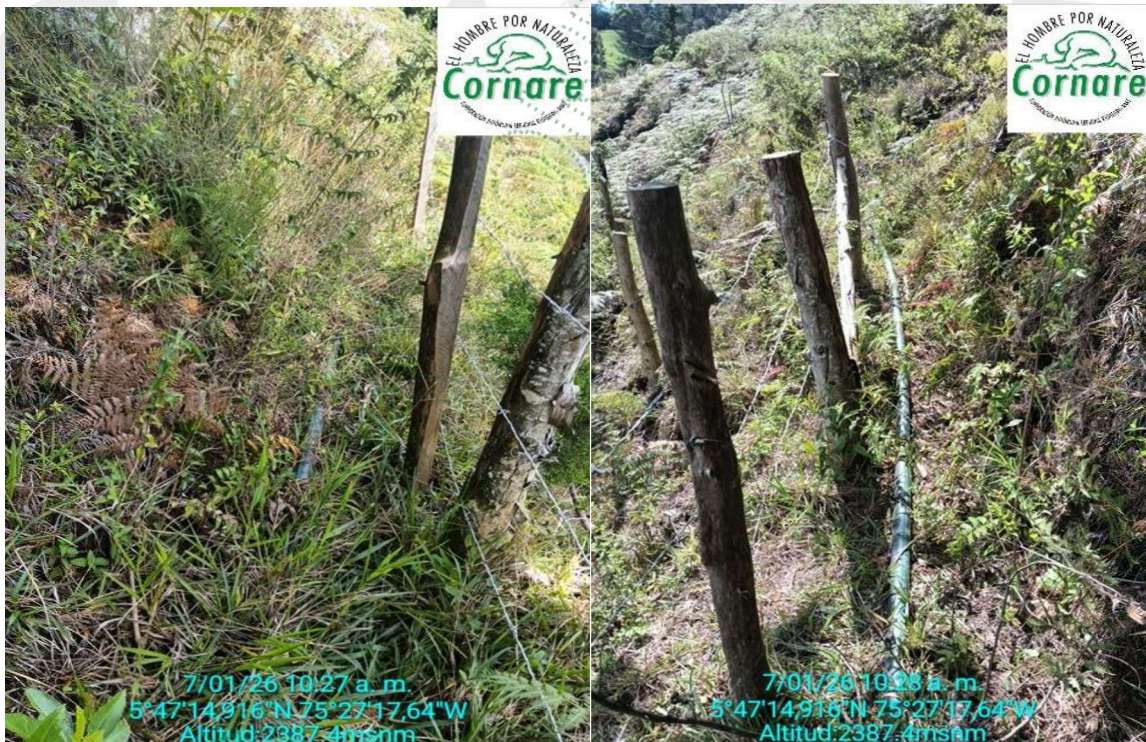
Manguera instalada por donde pasaba el cauce del nacimiento
