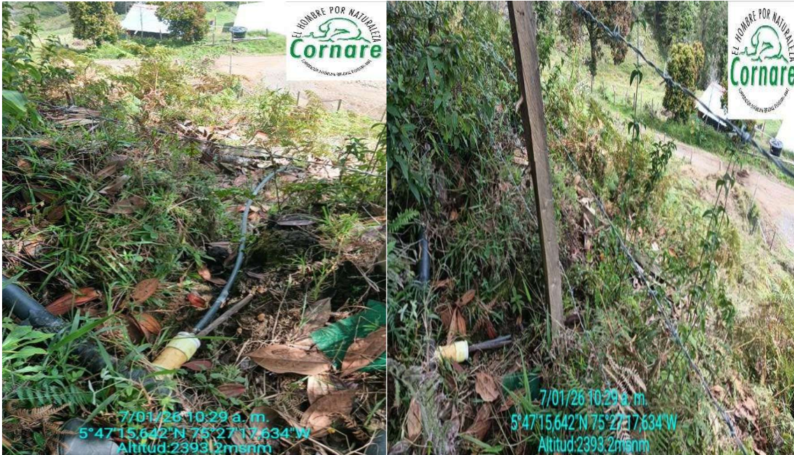
Derivación de agua para la vivienda del señor Darío del Río
