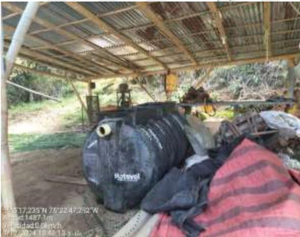
**Imagen 1. Pozo séptico desinstalado.**
