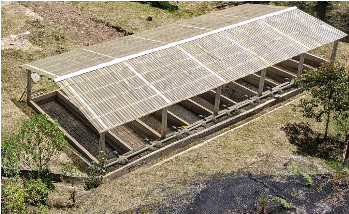
Fig 77. Lechos de arena.
