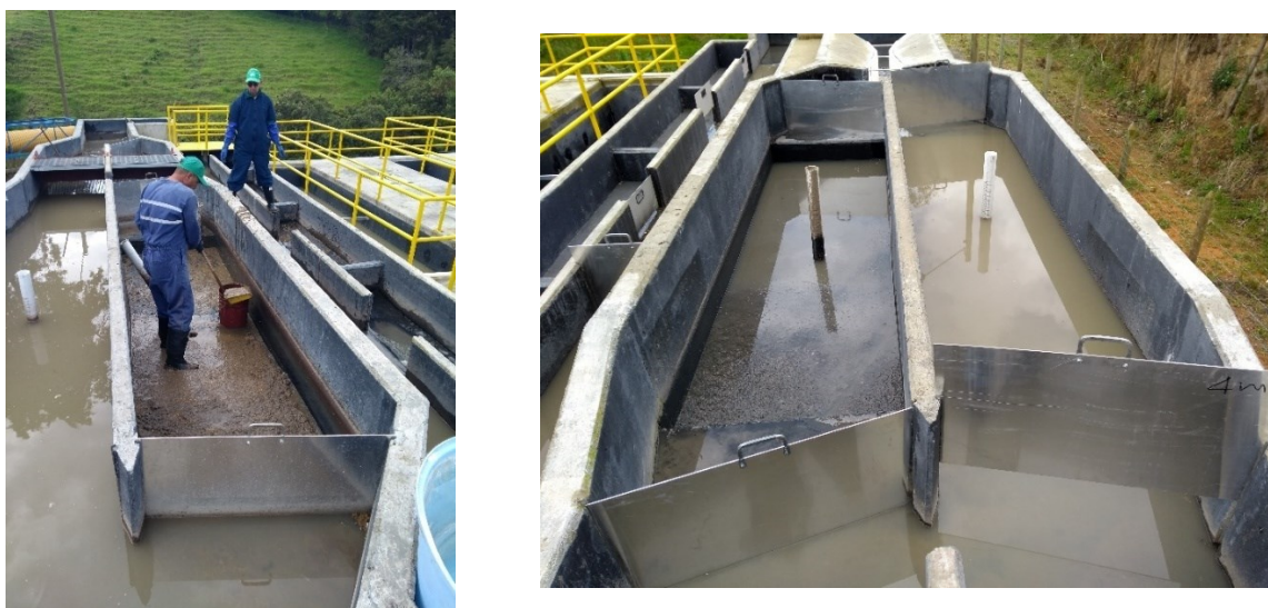
Fig 20. Operarios limpiando el desarenador.
