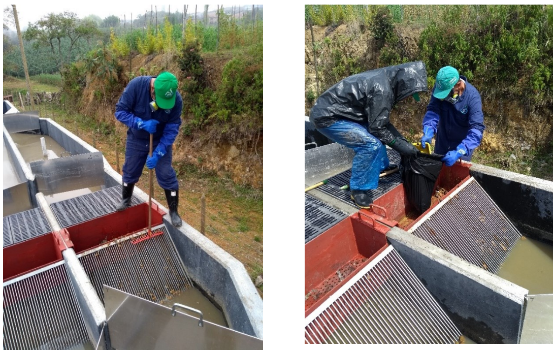
Fig 10. Operarios limpiando la reja.
