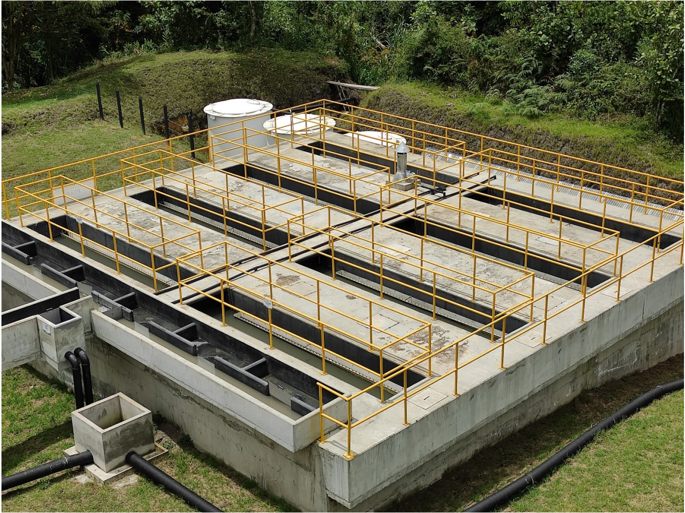
Lugar: reactor UASB de la PTAR Abejorral (2019).
