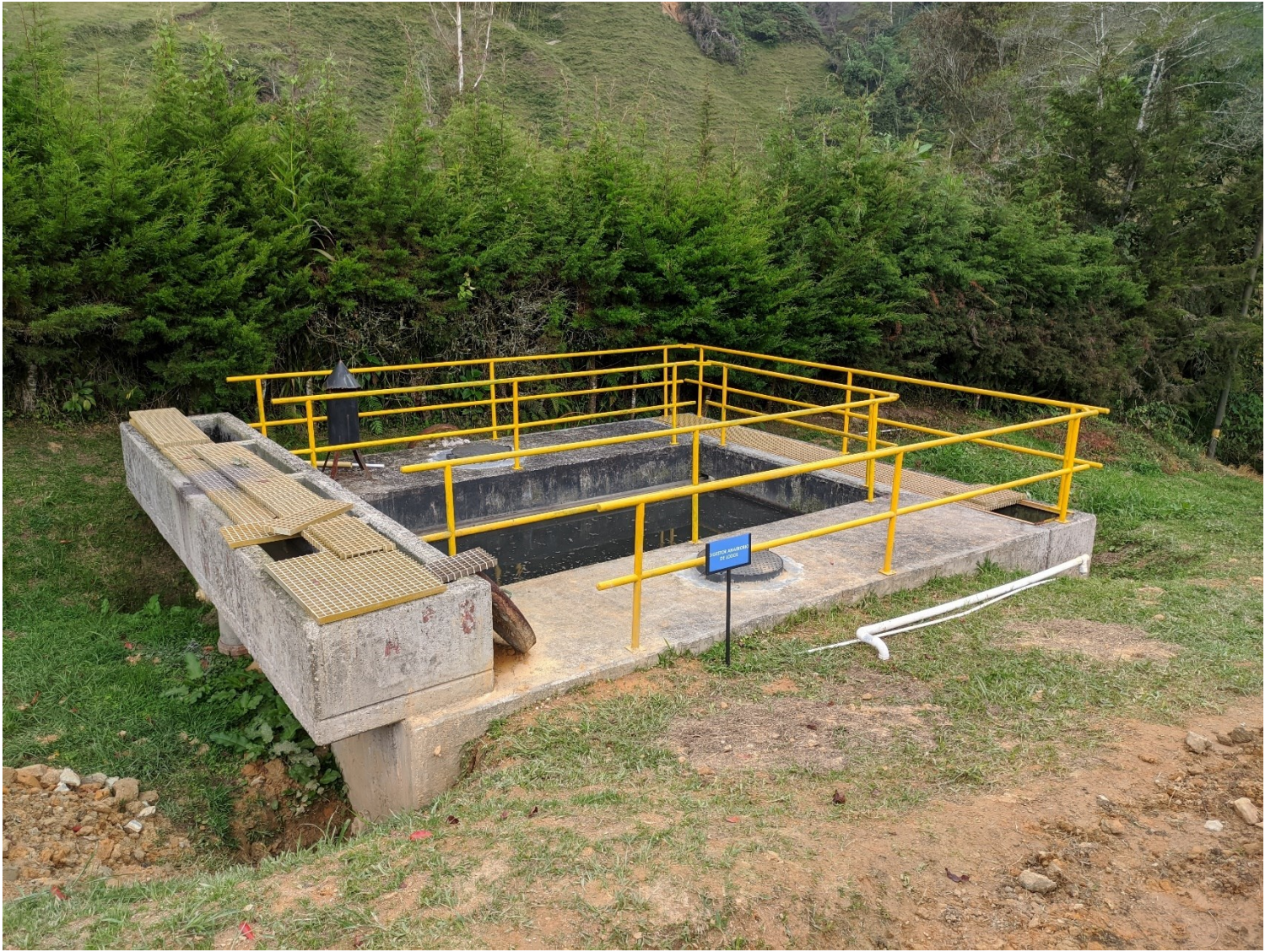
Lugar: reactor de lodos de la PTAR Granada (2021).
