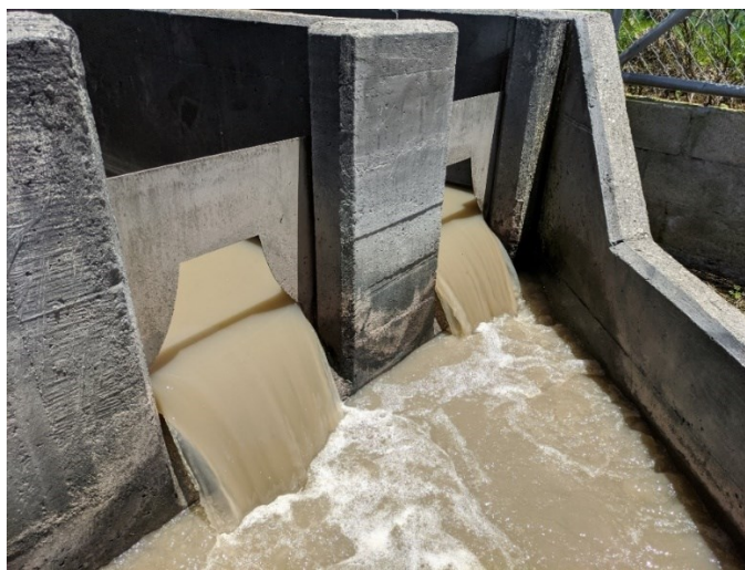
Fig 19. Vertedero sutro de la PTAR Marinilla.
