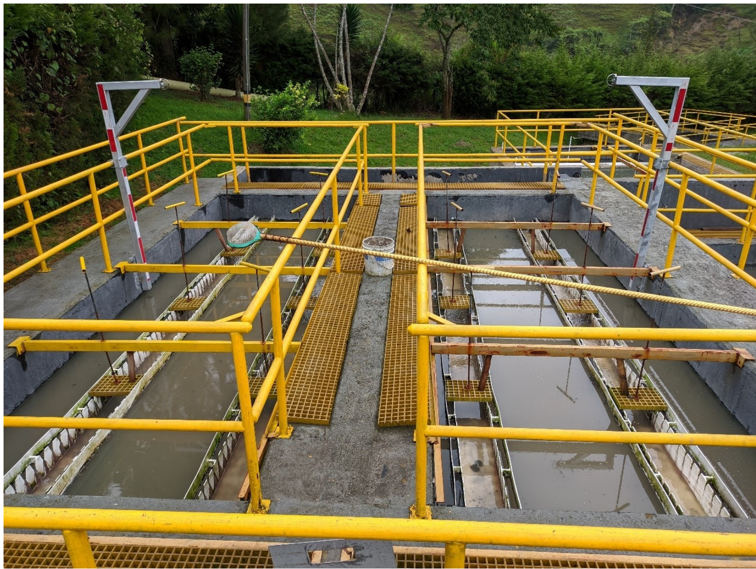
Lugar: sedimentador primario de la PTAR Granada (2021).
