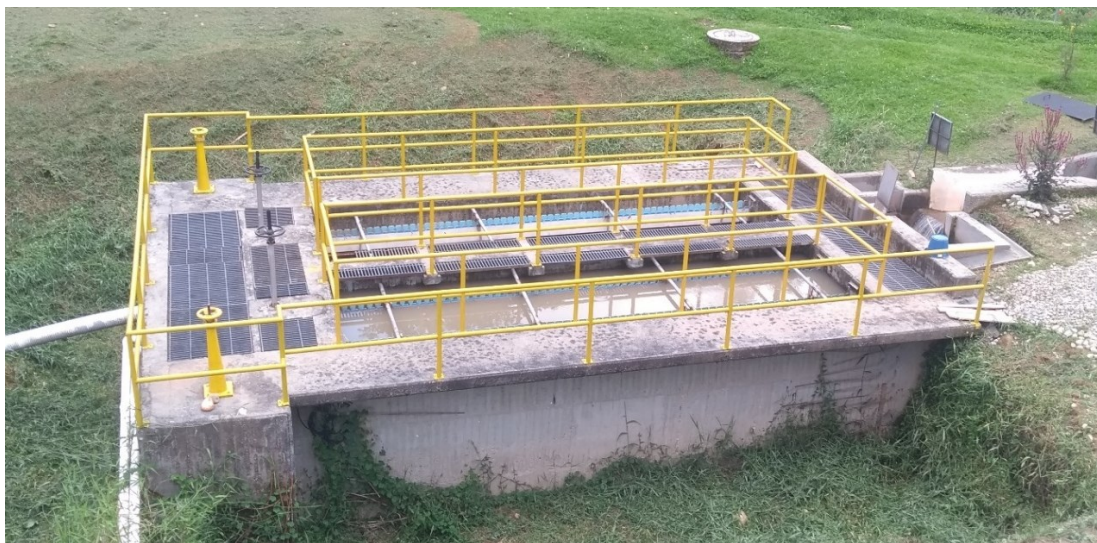
Fig 29. Sedimentador primario.
