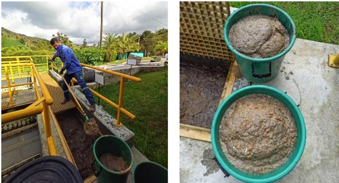
Fig 32. Operario limpiando el sedimentador.
