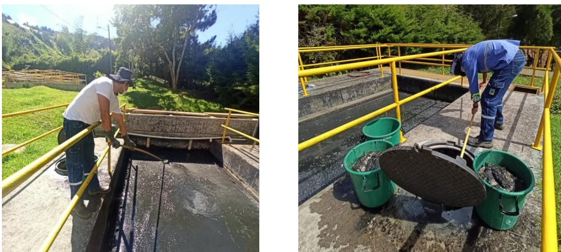
Fig 73. Operario limpiando el reactor de lodos.
