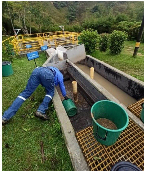
Fig 21. Arenas y sólidos extraídos del desarenador.
