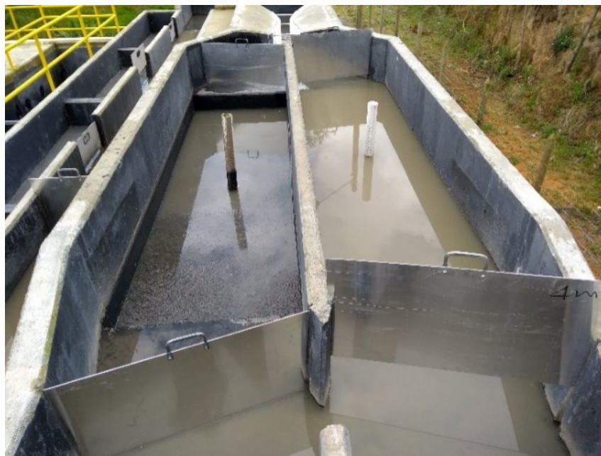
Fig 13. Desarenador de flujo horizontal.
