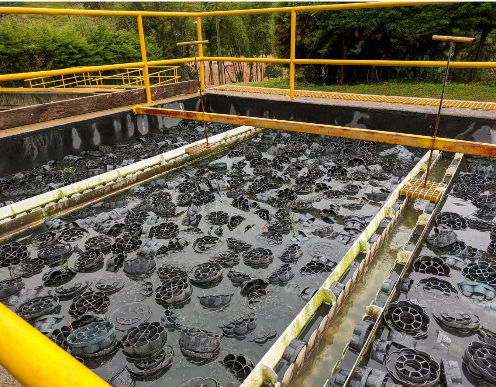
Lugar: reactor PBR de la PTAR Granada (2021). Este reactor no tiene la parte de sedimentación para clarificar el efluente por exceso de rosetas.
