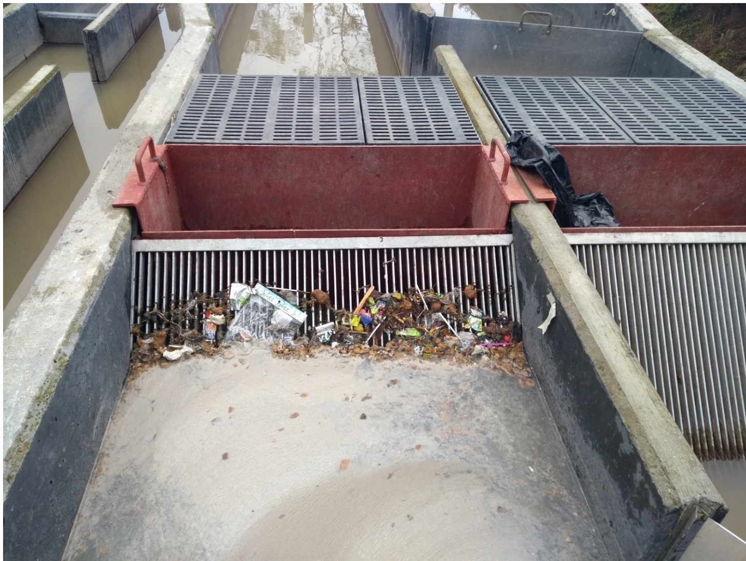
Lugar: rejas de la PTAR Sonsón (2018).
