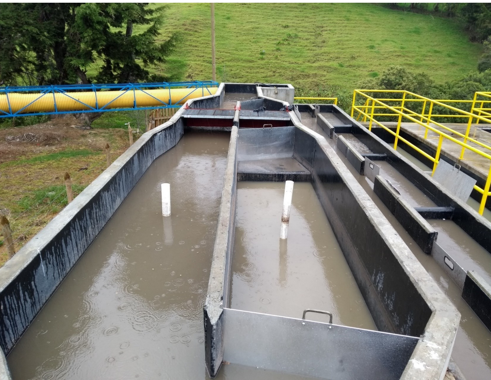
Lugar: desarenadores de la PTAR Sonsón (2018).
