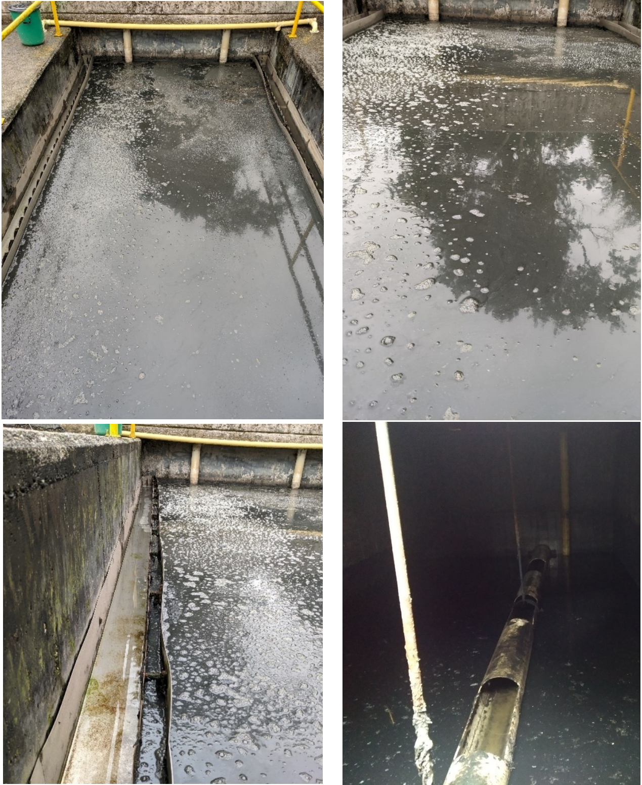
Fig 74. Sólidos flotantes extraídos del reactor.
