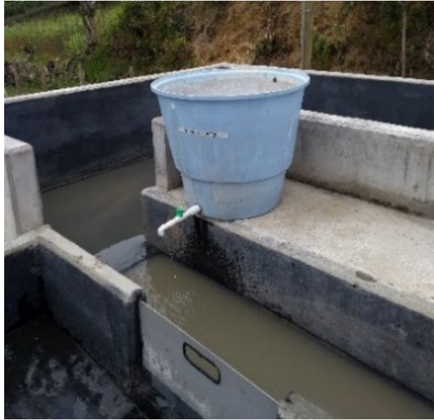
Fig 58. Adición de bicarbonato de sodio.
