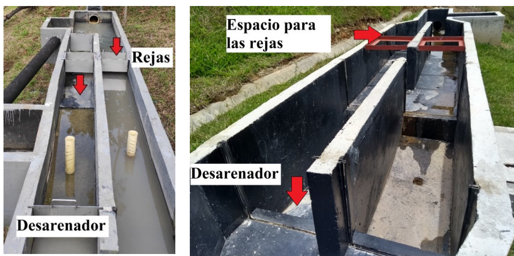
Fig 15. Rejas y desarenador.
