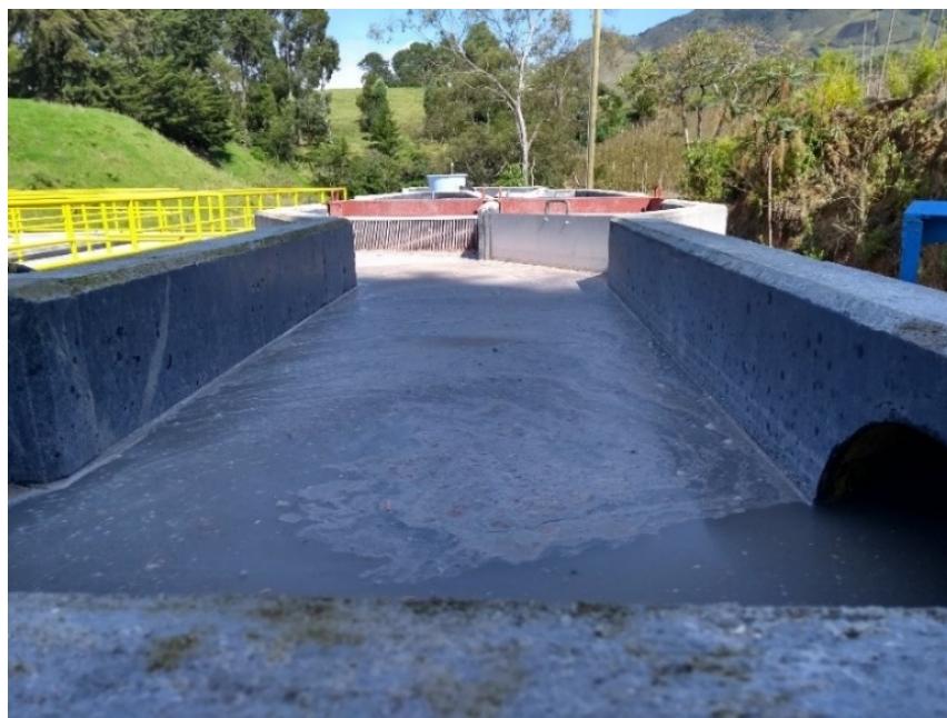
Fig 4. Aguas residuales que ingresan a una PTAR.
