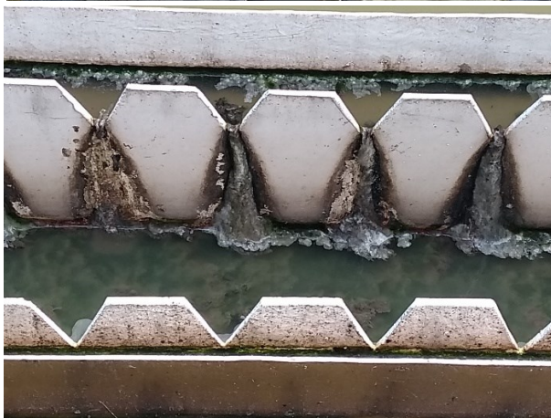
Fig 52. Sólidos flotantes extraídos del reactor UASB.
