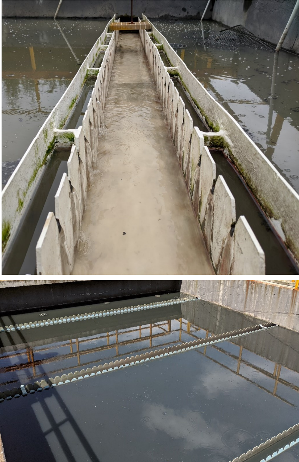
Fig 65. Canaletas del reactor PBR.
