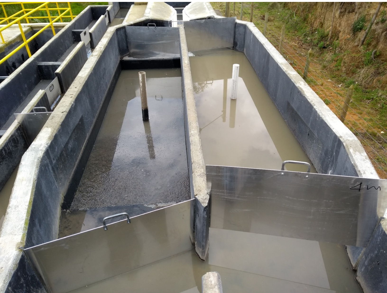
Lugar: desarenadores de la PTAR Sonsón (2018).
