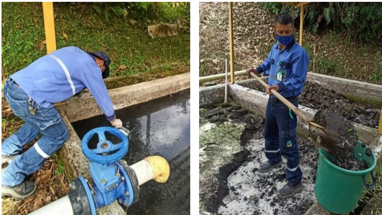
Fig 80. Operario ingresando lodos al lecho.
