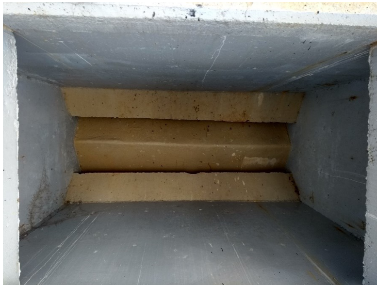
Fig 49. Aberturas del sedimentador.
