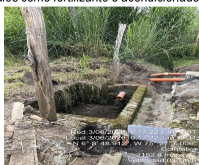
Canaletas de aguas residuales y sumidero actual
