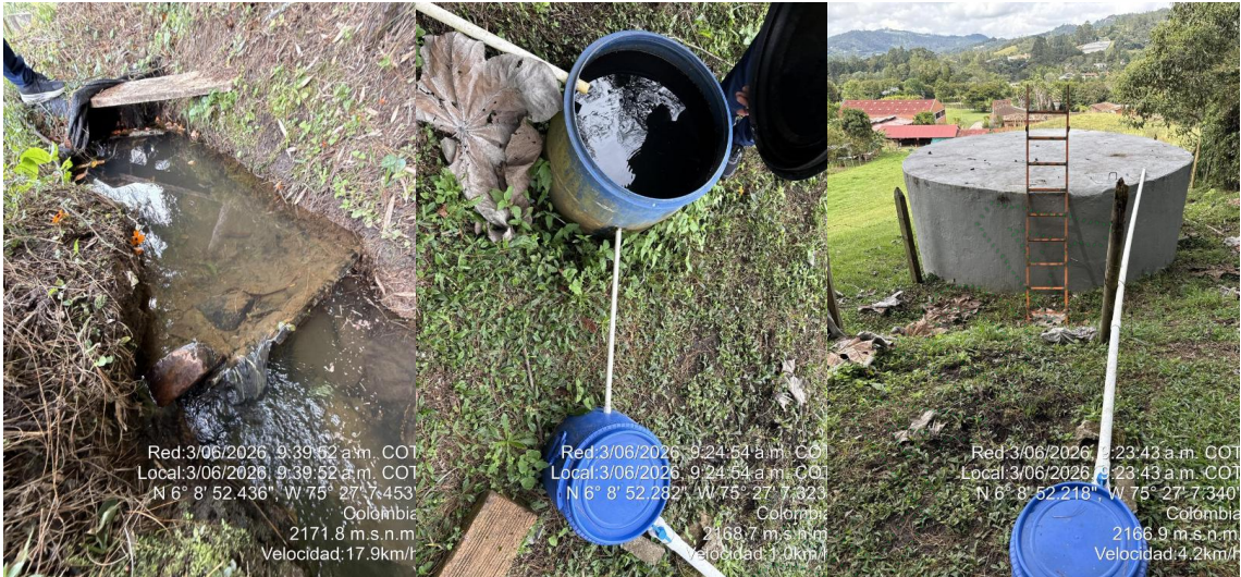
Sitio de derivación a la altura del predio Obra de control de caudal Tanque de almacenamiento
