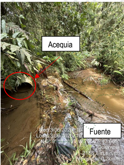
Sitio derivación de acequia
