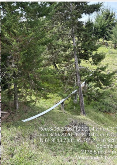
Tramo de acequia confinada
