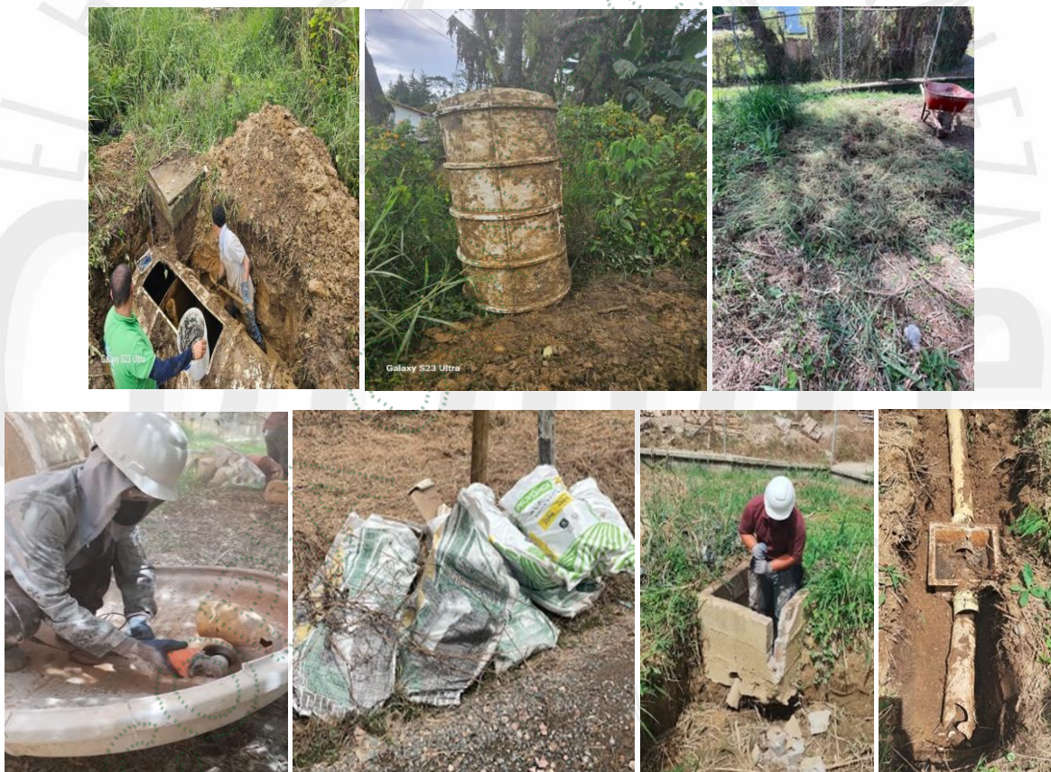
Imágenes relacionadas con el retiro del pozo séptico. Tomado de CE-20295-2025.
