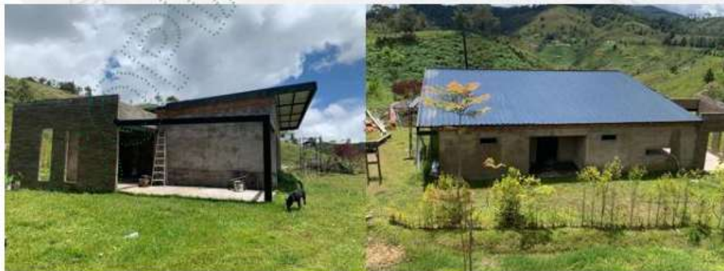
Figura 2. Vivienda en construcción.
