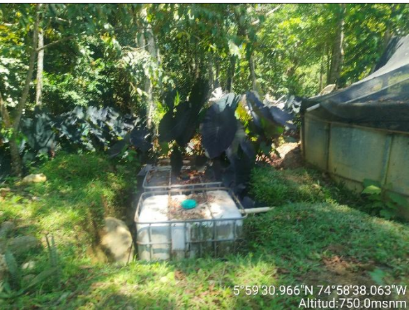
Figura 10. Isotanques con material filtrante para el tratamiento de las ARnD.
