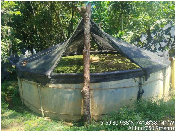
Figura 9. Tanque sedimentador para el tratamiento de las ARnD.
