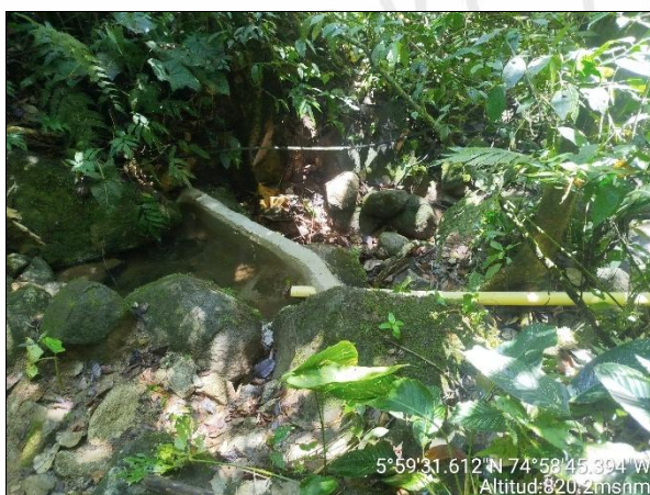
Figura 6. Bocatoma Q. Arroyo Seco.
