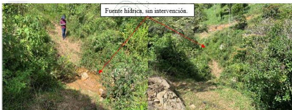
Figura 2. Ocupación de cauce sin obstrucciones y fajas de retiro recuperadas
